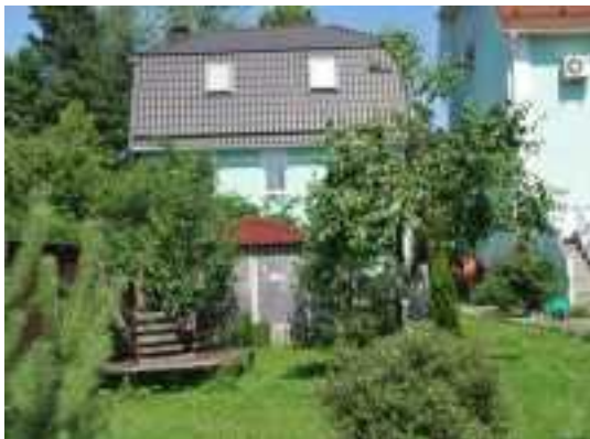
Снять коттедж на год по Дмитровскому шоссе 9км. от МКАД
